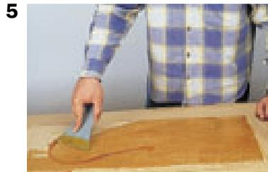
5. Encoller de la même façon le dos du stratifié découpé. Laisser sécher la colle sur les deux surfaces environ 10 minutes (respecter le mode d'emploi de la colle utilisée), jusqu'à ce qu'elle ne poisse plus si on y pose un doigt.
